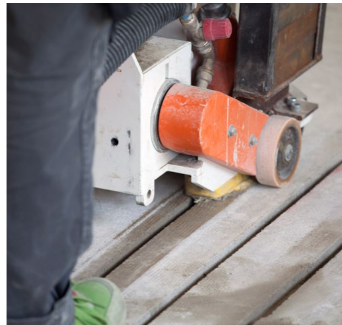
Präzises Einfräsen der Vertiefungen für die Bodenheizungsrohre
